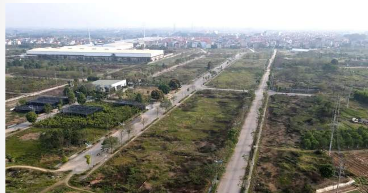
Hàng loạt dự án khu đô thị ở huyện Mê Linh (Hà Nội) đang "đắp chiếu" do nhiều nguyên nhân, trong đó có vướng mắc giải phóng mặt bằng và điều chỉnh quy hoạch
